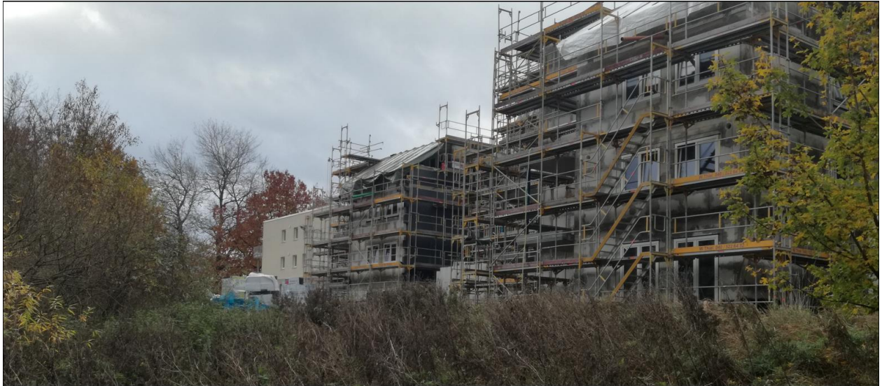
Abbildung 4: Beispiel der Art der Bebauung in der Bauphase
