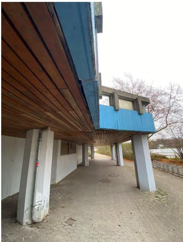
**Foto 5: Kleinbahndamm südlich des Aqua Siwa. Holzverkleidung mit Lücken und Spalten.**
