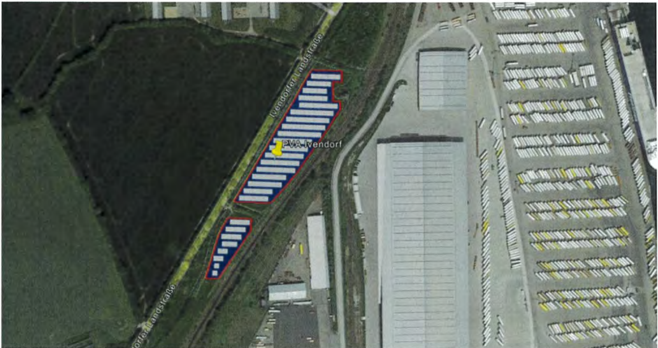
Bild 2.1.2: Detailansicht der PV Flächen (Quelle: Google Earth/SolPEG, Nordausrichtung)
