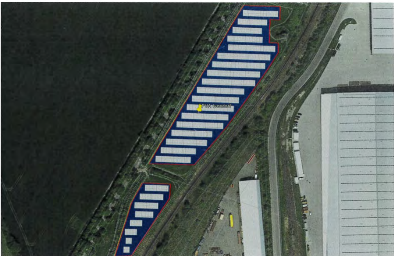
Bild 2.1.3: Detailansicht der PV Flächen (Quelle: Google Earth/SolPEG, Nordausrichtung)
